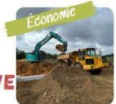
✳️ Début des travaux de la deuxième ZA du Poteau - octobre 2024
